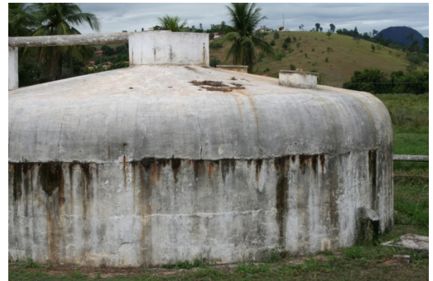
Foto 4 – UASB em ferro-cimento
