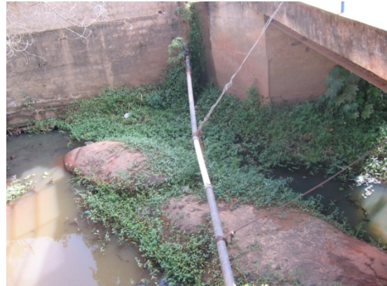
Foto 8 Travessia no Córrego Ferrujão
